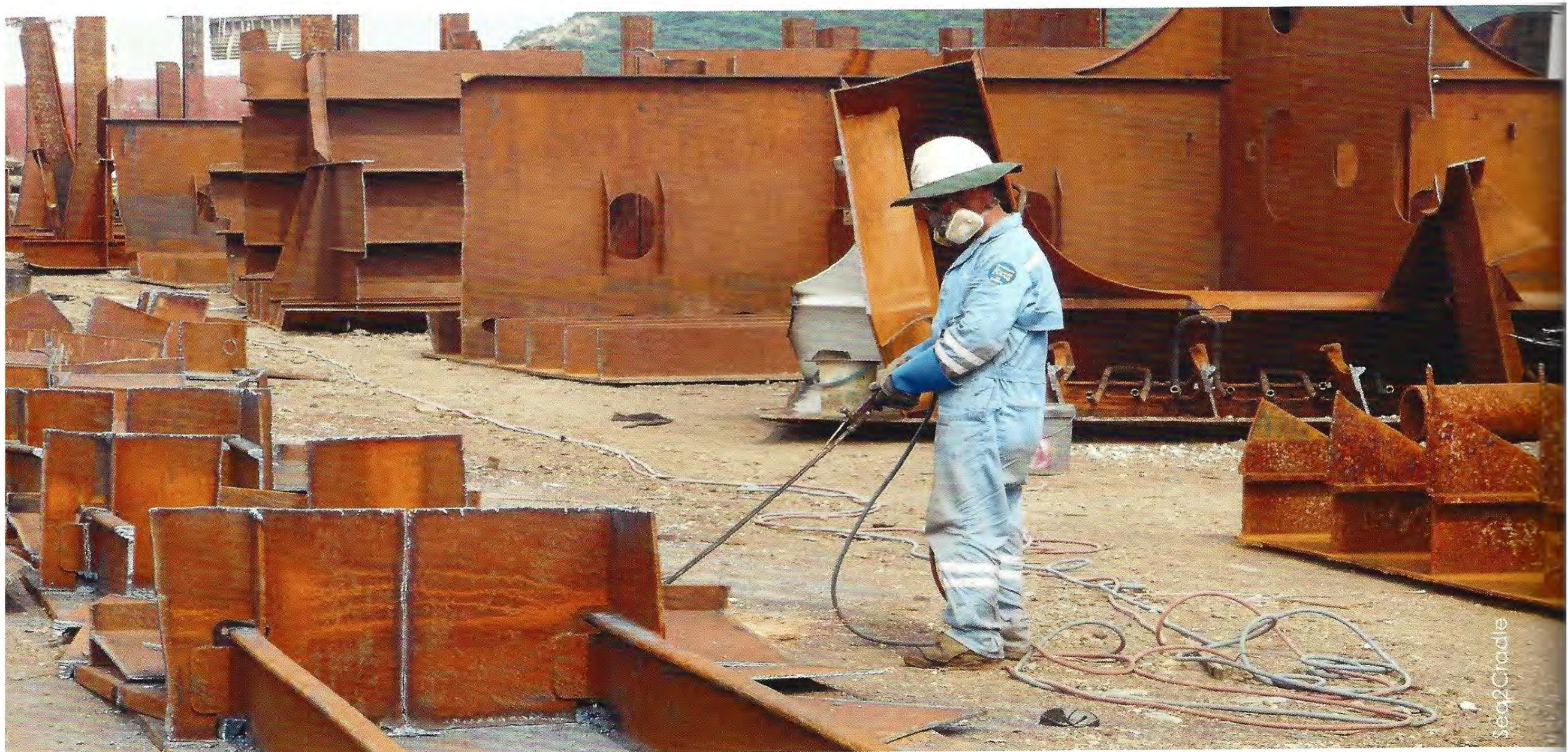
▲ Staal secties worden op de kade met een gasbrander in handzaam formaat gesneden.
